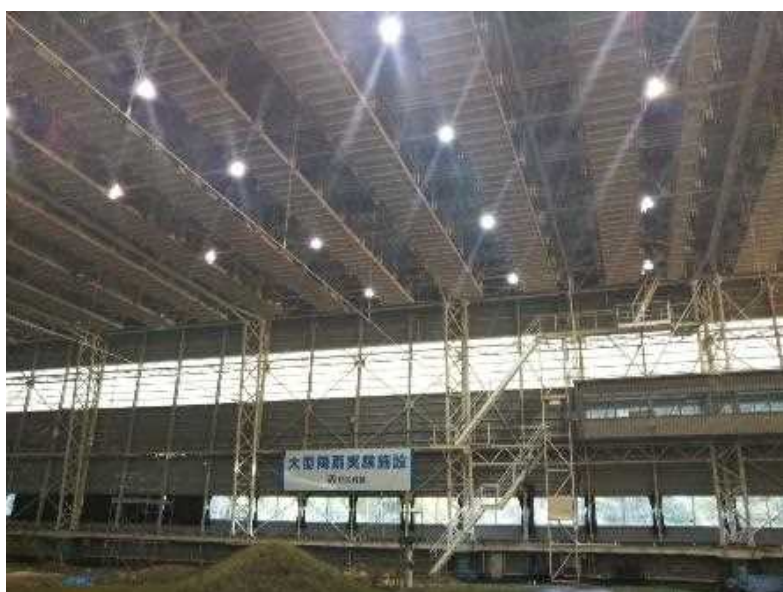
大型降雨実験施設
